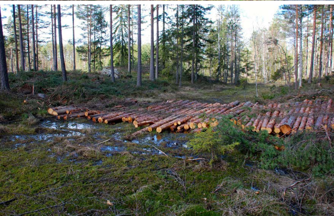
Översta bilden: Virkesbro över en skogsbäck. Lägg märke till att på- respektive avfarternas risats ordentligt för att undvika körskador. Nedersta bilden: Exempel på en kavelbro över ett surdråg. På- och avfarternas har även förstärkts med ris vilket ytterligare minskar risken för körskador. Foto Ulf Ormestad.
