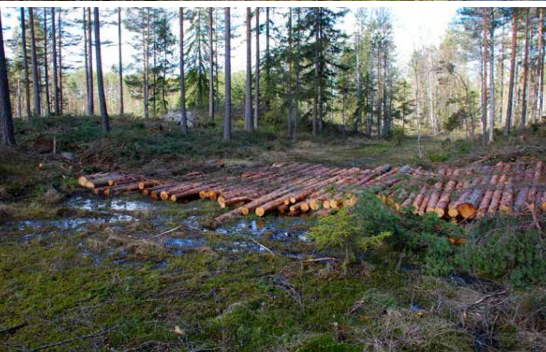
Översta bilden: Virkesbro över en skogsbäck. Lägg märke till att på- respektive avfarternas risats ordentligt för att undvika körsador. Nedersta bilden: Exempel på en kavelbro över ett surdråg. På- och avfarternas har även förstärkts med ris vilket ytterligare minskar risken för körsador. Foto Ulf Ormestad.
